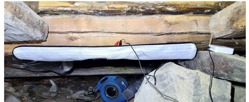
InfraVivo IR Torkfilt - fälttest Krypgrund
